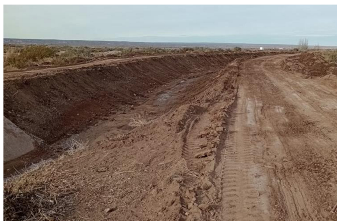
Ilustración 1-8 Tramo del canal La Picacita en buen estado
