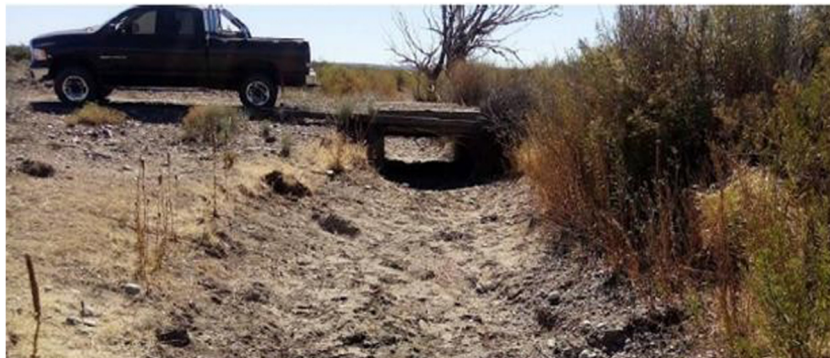
Ilustración 1-4 Vista de una alcantarilla del canal
