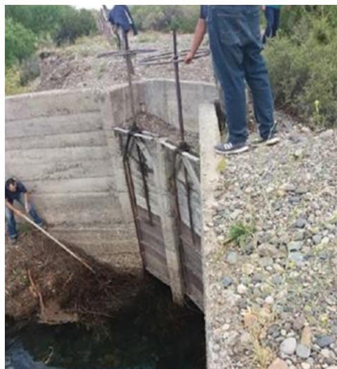
Ilustración 1-3 Vista de la obra de captación - canal Fortín Nogueira
