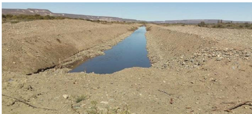
Ilustración 1-5 Vista de la nueva sección del canal principal
