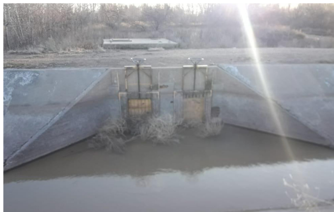
Ilustración 1-10 Ingreso sifón de cruce arroyo Picún Leufú, margen derecha del arroyo
