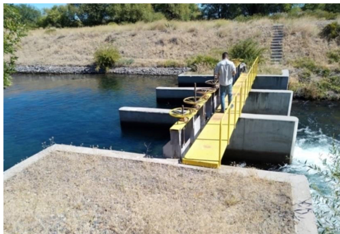
Ilustración 1-7 Obra de toma en buen estado del canal La Picacita
